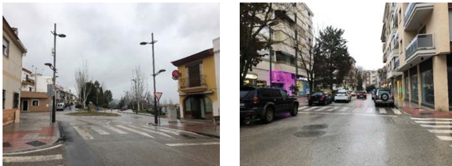
Ilustración 20. Ejemplos de rebajes en acerados
