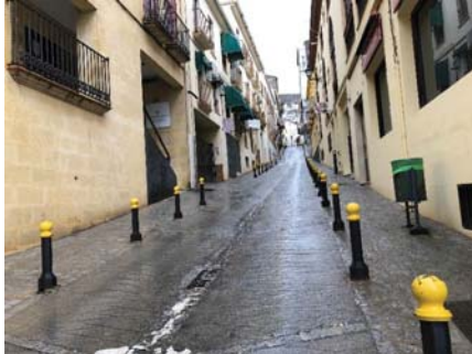
C/Fuente Nueva. Pivotes y mobiliario urbano dificultando el tránsito peatonal
