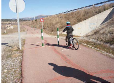
Ilustración 30. Estado actual del carril bici en su tramo paralelo a la carretera A-403
