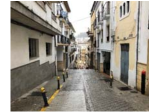
Ilustración 11. C/Fuente Nueva. Hormigón
