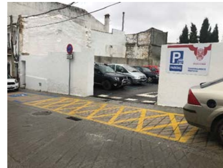
Ilustración 4. Aparcamiento público en C/Real
