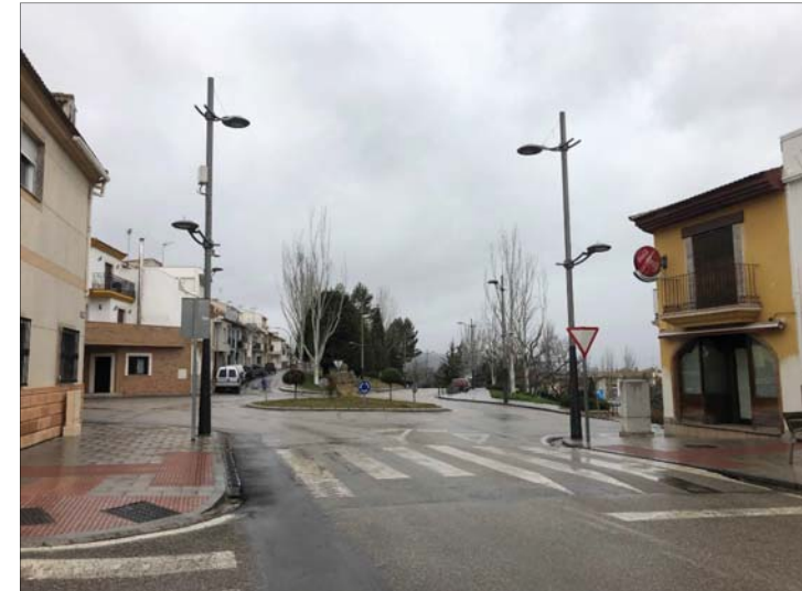
Ilustración 26. Paso de peatones sobreelevado. Si existe continuidad acera-paso. En vez del pavimento táctil direccional se ha colocado baldosas de botones.
