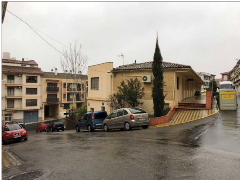
Ilustración 21. Cruce calles Córdoba, Miramota y Llanete del Mercado. El cruce carece de señalización.
