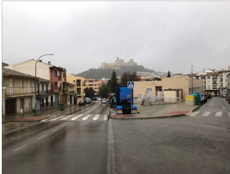
Ilustración 28. El paso de la izquierda es un paso sobreelevado al que le falta el pavimento táctil direccional. El paso de la derecha, a pesar de tener el vado rebajado, se aprecia una discontinuidad entre la acera y la calzada. Además, carece de la señalización vertical necesaria y del pavimento táctil direccional.
