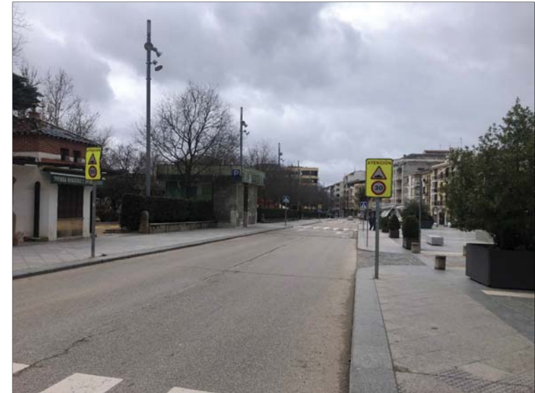
Ilustración 30. Pasos en la calle Álamos. A pesar de tener el rebaje del acerado y buena señalización, en los vados se carece del pavimento táctil así como direccional.
