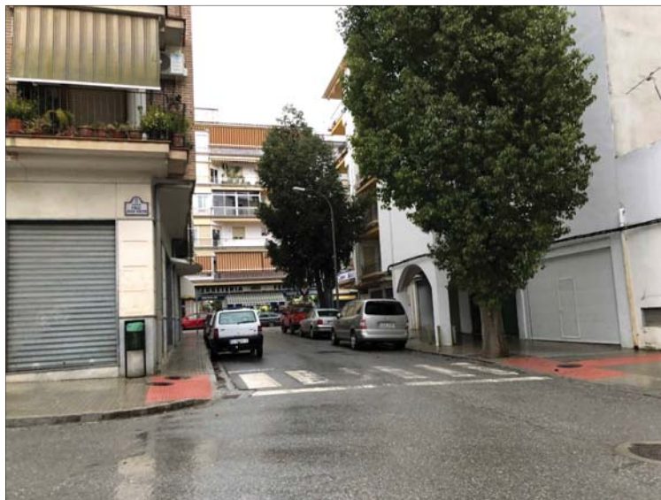
Ilustración 29. Paso con rebaje en acerado. Falta el pavimento táctil direccional y la señalización vertical.
