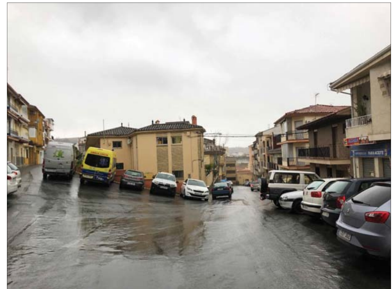
Ilustración 19. Zona amplia de la Calle Llanete del Mercado. Carece de señalización horizontal.
