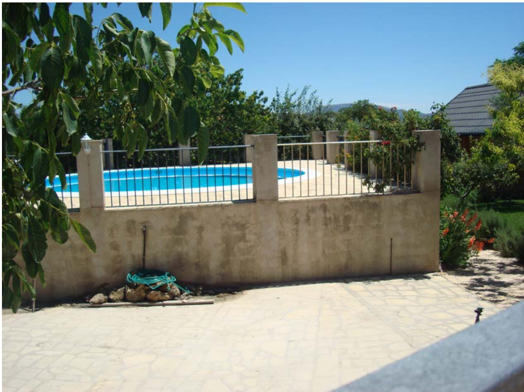
PARCELA VALLADA, CON CASA DE MADERA, CASA DE PIEDRA, 2 CASETAS DE RIEGO, PISCINA E INVERNADERO EN FINCA nº 92
