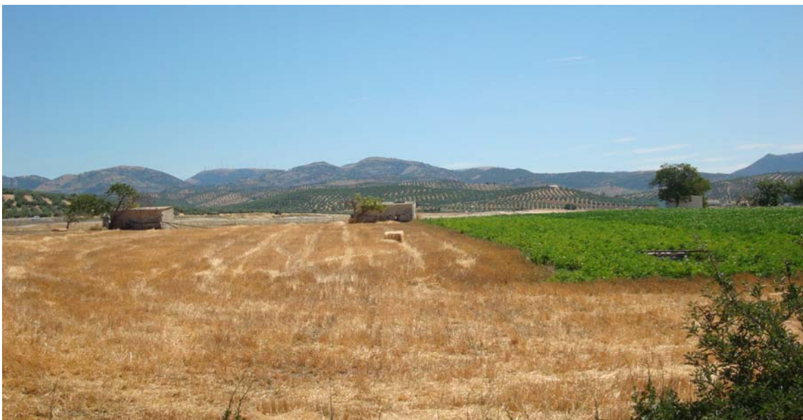
CASETA DE PIEDRA EN FINCA nº 61
