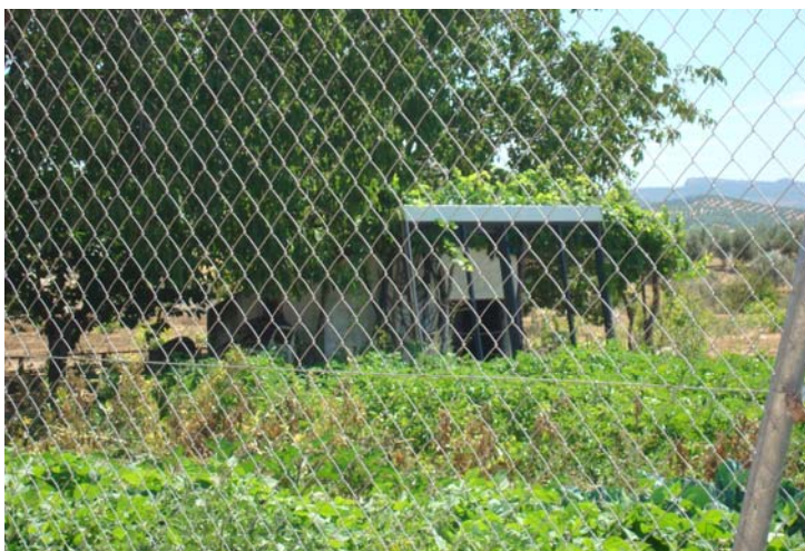
CASETA DE RIEGO, RULOTTE y PISCINA en construcción EN FINCA nº 81
